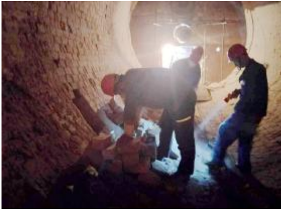
近期,山西中铝工服公司筑炉施工处对第一氧化铝厂 4 号回转窑进行中修,参战人员在窑筒内 50 多摄氏度的高温中铺砖、扬料打灰、注料,连续奋战 8 个昼夜,保质保量地完成了回转窑检修任务。摄影报道 丁庆江
