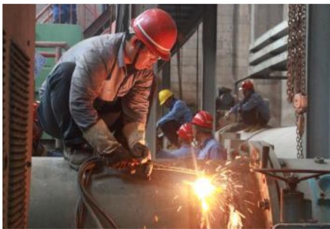
6月12日,热电厂与晋铝冶炼检修施工单位通力协作,抓住高压溶出五系列停汽检修有利时机,组织人员连续奋战13小时,顺利完成了新系统循环水停产检修任务。施工中,检修人员分别完成开关柜、真空开关、过电压保护器等试验操作17组台、电压互感器一组,电缆试验二根,更换清理冷水系统进、出口阀门8台等,提前3小时恢复新系统循环水系统,保证了安全稳定生产。图为检修员工补焊循环水冷水泵泵体。
