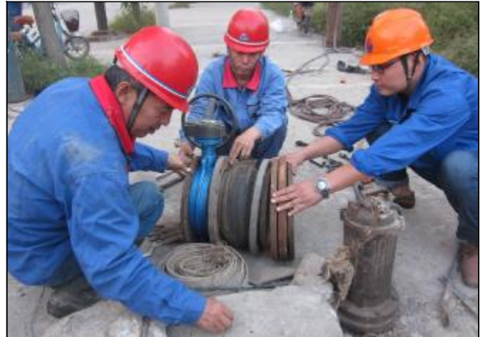
近日,生活服务中心维修二车间党支部结合专项工作,通过集中保养、润滑打磨、修配改代,一举攻克了各类锈蚀阀门的更换和维修难题,在提高工作效率的同时,有效节约了材料和人工成本。图为该车间党员在维修现场商讨给阀门的安装方案。 摄影报道 王海雷
