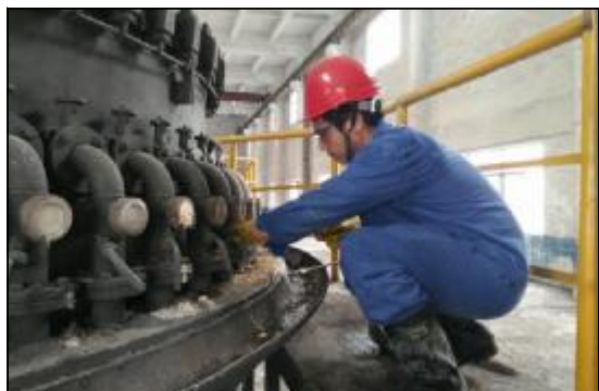
近日,第二氧化铝厂精制车间对叶轮破损取样管采用“换”为“堵”的方法检修,将目镜拆下后用同样大小的薄钢板封焊,经过试验,叶轮机不仅顺利开车,生产压力大大缓解,并且节约备件费近千元。摄影报道 田慧
