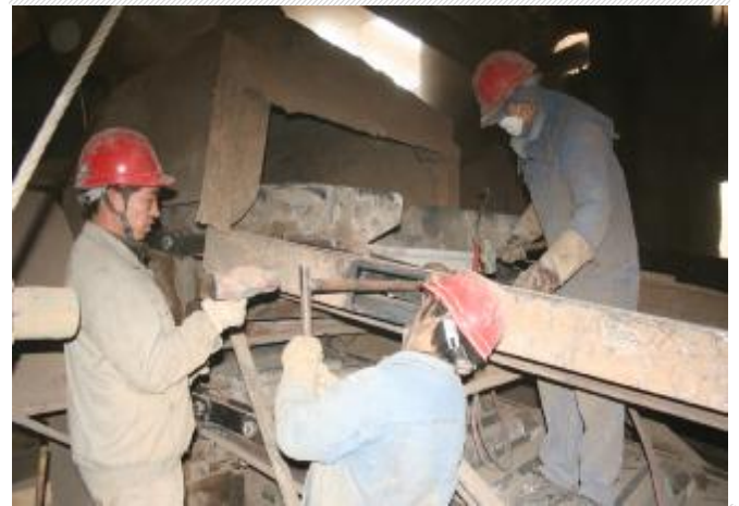
俗话说“三分修,七分养”。8月份开始,山西中铝铝服修造车间将常态化点检、润滑应用到氧化铝包保项目中。该车间结合包保项目实际生产情况,对第一氧化铝厂2号、4号斜斗加强点检、维护,通过加强设备润滑投入,促进备件的寿命延长,进一步提高设备工作效率,在保证设备的正常运转的同时,延长大修周期,降低维修费用。图为施工人员进行在对斜斗进行检修。 摄影报道 张安洋
