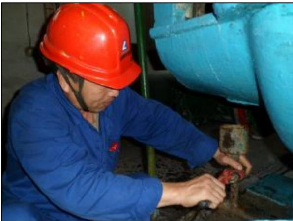
日前,水电分厂一车间严格按照“深化运营转型 强化现场管理”专项行动推进计划,对车间所辖的20余台水泵滴水槽进行改造,统一更换为镀锌管制作的滴水槽,且加粗加长,直接通到地沟,有效防止钢管腐蚀和堵塞,切实做到作业现场“一零、二净、三清、四无、五不漏”。图为检修人员对滴水槽改造。
