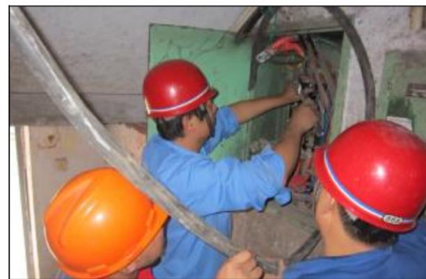
近日,生活服务中心维修二车间排查维护用电线路设备,车间技术人员对箱式变电站、配电室、电表箱等故障多发点逐个检查,及时处理线路老化、设备接地不可靠、插座开关接触不良等用电隐患,减少因线路故障而给居民带来用电问题。图为技术人员在处理朝霞23栋停电故障。摄影报道 王海军
