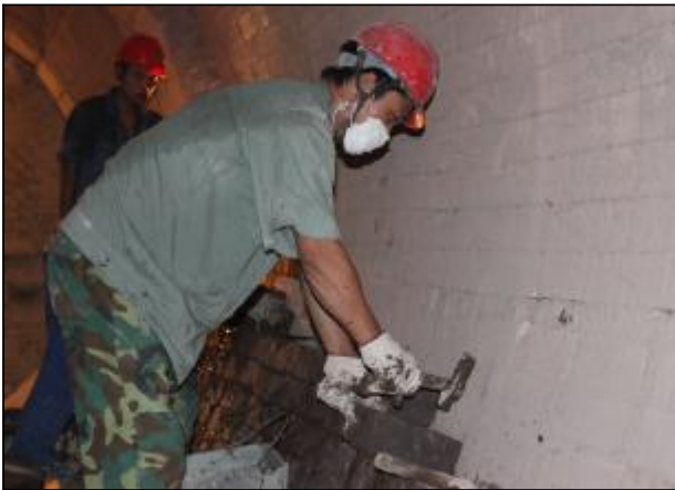
9 月 8 日,山西中铝工服炉修车间放弃中秋节假日,抢修第二氧化铝厂 1 号石灰窑。车间结合现场实际,提前清理窑内检修现场,施工人员克服高空作业、粉尘不利因素,吊装、搅拌、搬运、砌筑等环节默契配合,按时间节点圆满完成了抢修任务。图为员工砌筑耐火砖。摄影报道 杨鹏霞
