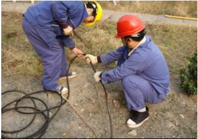
近日,运输部水电段开展隐患排查专项整治活动,重点巡视穿越铁路地段的电气、通讯管网设施,修复路基沉降造成的电缆裸露故障。图为员工更换通讯电缆。 摄影报道 丁剑锋
