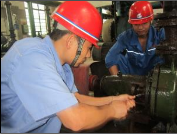
为进一步降低维修成本,近期,生活服务中心维修二车间以岗位练兵活动为载体,立足车间实际,将水泵维修等原属于外委检修项目转为自修,大大提升员工综合素质的同时,年可节约检修费用万余元。图为车间技术人员正在维修交换站水泵。
