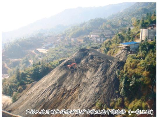
已投入使用的九谋锡矿尾矿陶瓷压滤干堆渣场(一期工程)
