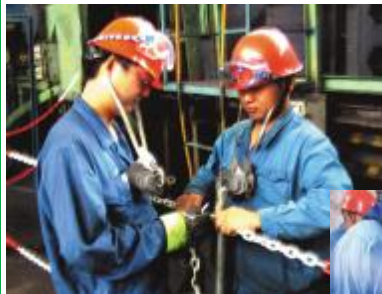
碳素厂二焙烧把安全责任制落到实处,通过加大安全隐患的整改,实现了安全生产。图为员工在增设设备安全防护栏。(钟翔 摄)
