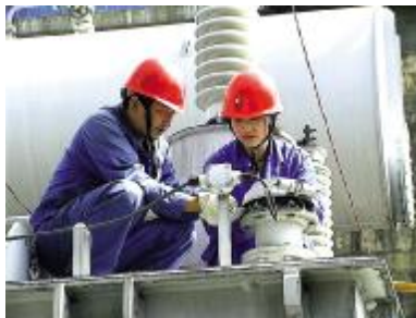
为确保电解铝生产的稳定运行，计控厂电气车间员工认真维护一供电的仪器仪表装置。图为电气车间员工在一供电检修仪器仪表。何志生 摄
