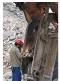
石灰石矿机修钳工检修电铲铲斗。(姚建中 摄)
