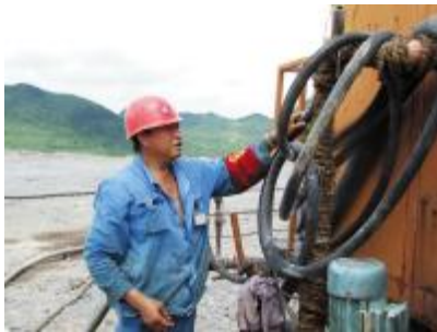
顶烈日、冒严寒,春夏秋冬不畏难,是露天采矿工人的真实写照。图为石灰石矿潜孔钻工正在进行中深孔爆破的钻孔作业。(刘宏飞 摄)
