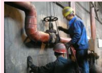
华阳公司成型利用停产间隙,抓紧抢修更换煤炉导热油管道阀门,抓紧抢修做好准备工作。(谢东滨)
