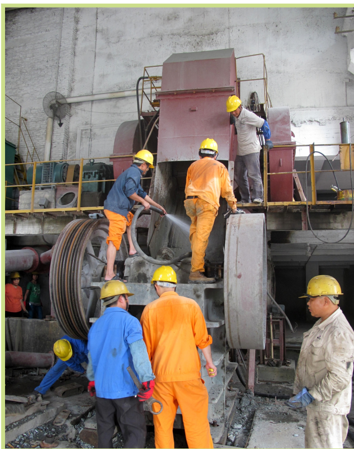
图为员工在齐心协力修复破碎机老虎口
