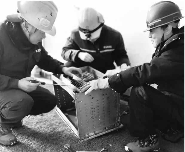
萨热克铜矿技术员组装配电柜。
