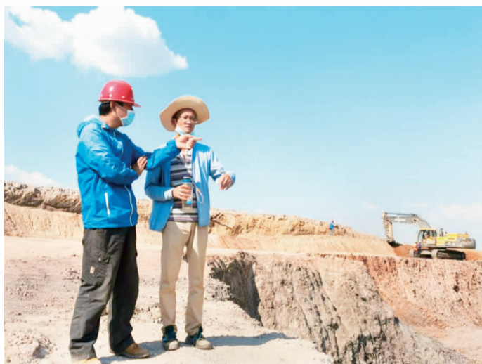
▲工程技术人员现场沟通技术问题。
