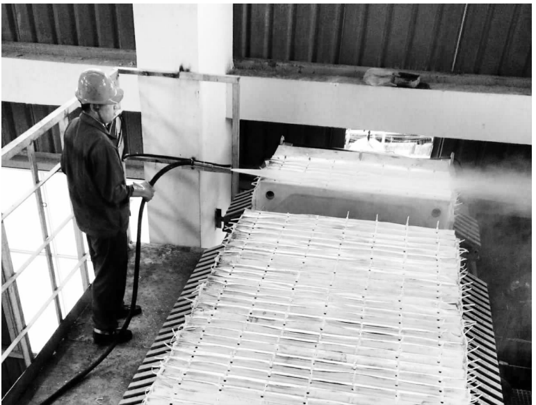
岗位人员冲洗板框。
