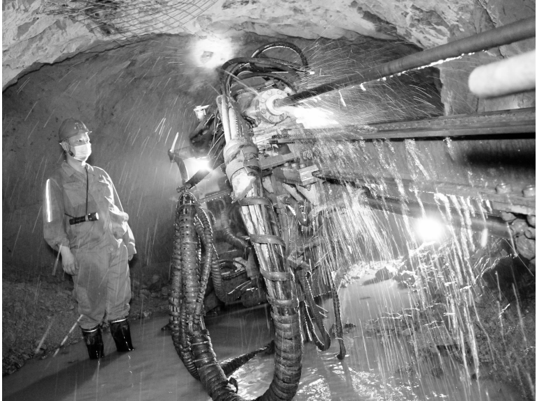
▲改造后的CMJ1-14掘进台车在5510采场作业。
