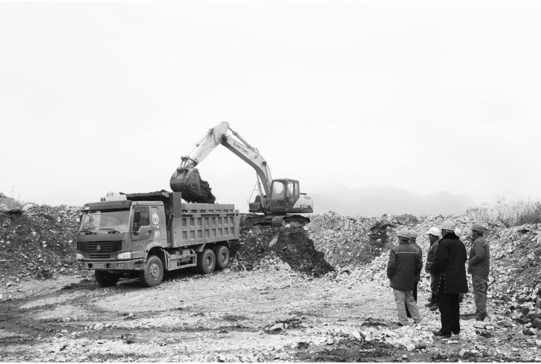
矿业分公司铜山口矿南部境界优化施工项目进行前期安全整改。
