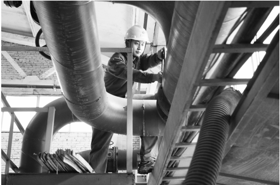
职工在开启阀门调节系统进风。
