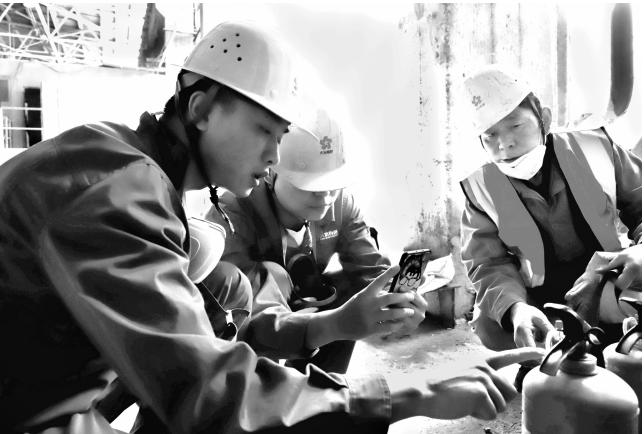
新入职大学生检查消防器材。 鲁方昆 摄
