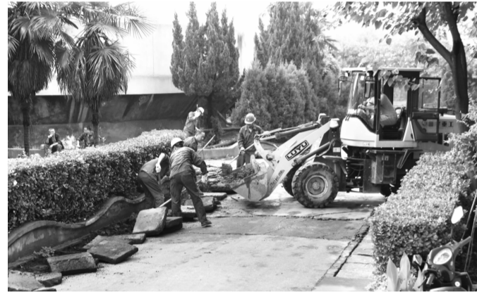
厂硫酸党总支组织党员对污水系统进行清理,确保系统汛期生产安全。
