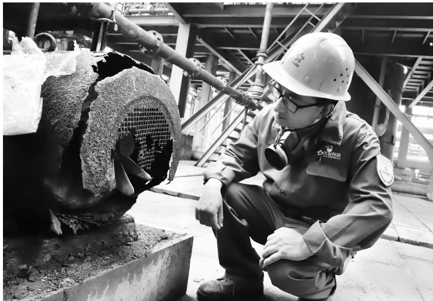
厂专职安全员正在查找现场安全隐患。
