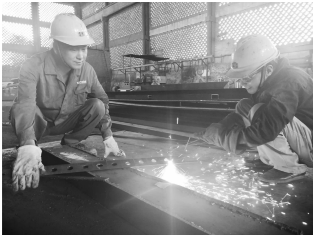
维修班职工制作浮船保安全降成本。
