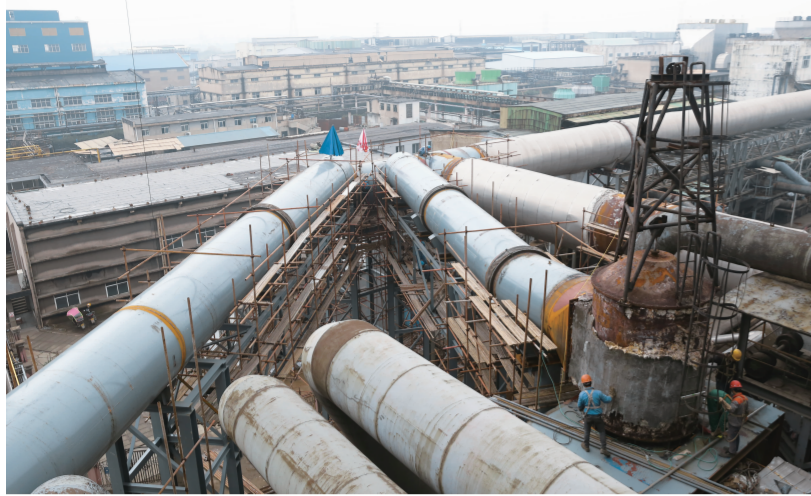
金格建安公司在冶炼厂澳炉第七次停产检修中承接的主烟管道检修项目按期完成。
