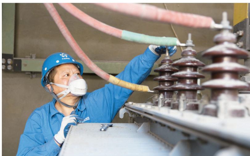
金格动力分公司对厂区变压器进行维护检修,保障日化生产。
