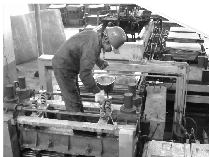
党小组成员给机组“换新装”。
