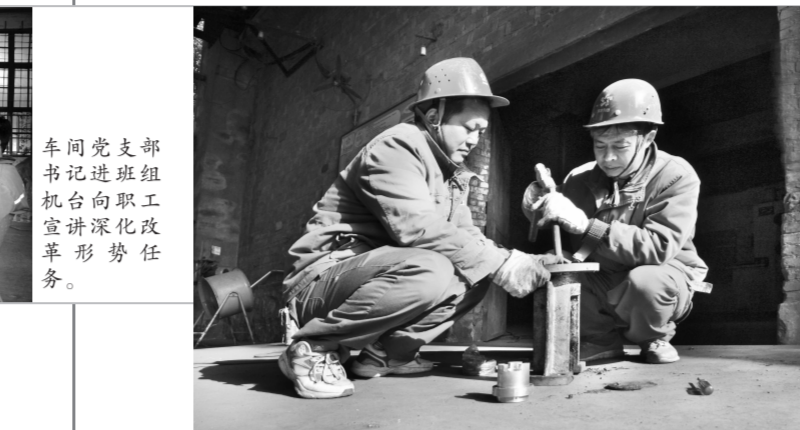
党员开展修旧利废维修电动阀门。
