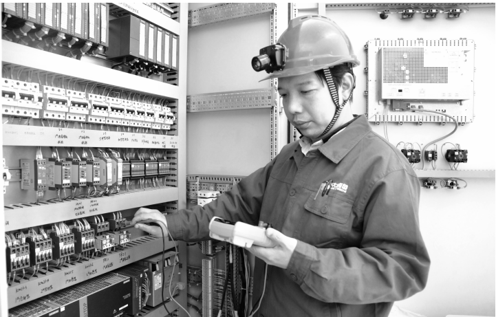
▲雷文在检查混合井主提升机恒减速液压闸控系统。
