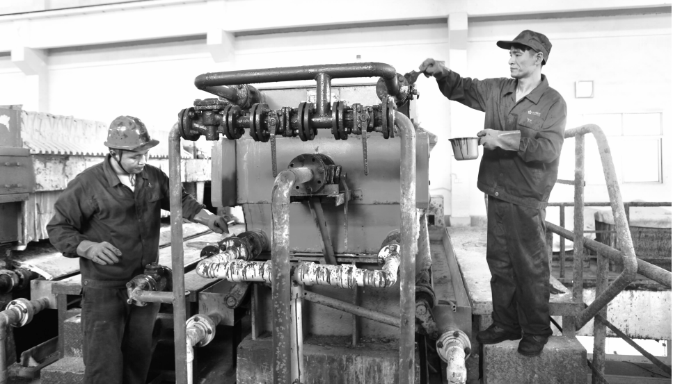
▲ 精炼车间开展党支部共建活动,对设备进行维护保养。
