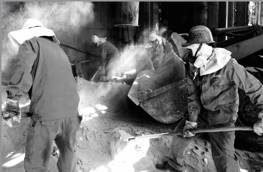
在澳炉第七次检修中,冶炼厂精心准备、周密部署,按照检修计划倒排工期,明确各项检修施工节点,领导、项目负责人每天深入检修现场,对检修安排、施工方案落实以及与各施工单位协调配合事宜进行检查指导,确保检修安全、质量和进度。目前,澳炉检修工作进展顺利,有望提前一天完成检修任务。因为转炉车间职工在清理主烟道烟灰。
