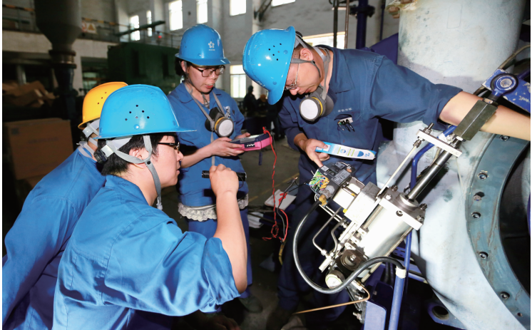
▲ 冶炼厂自主维修澳炉3K风机。
