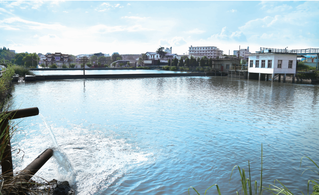
▲ 6#泵房蓄水量保持78%。
