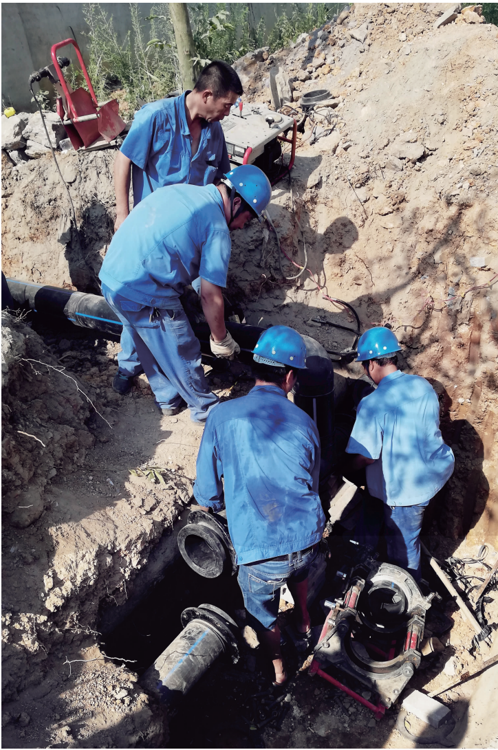
金格动力职工在户外高温下抢修供水管道。(柯翔 摄)
