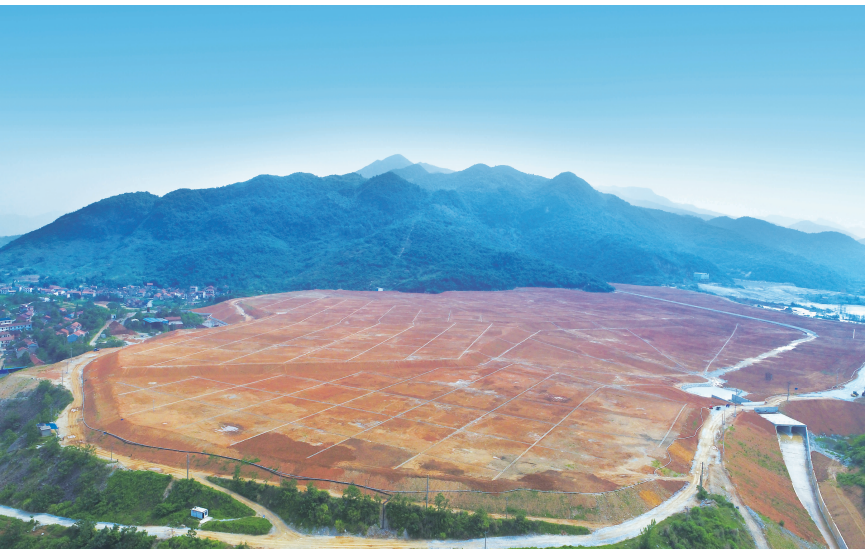
▲ 铜山口矿周家园尾矿库闭库工程鸟揽。
