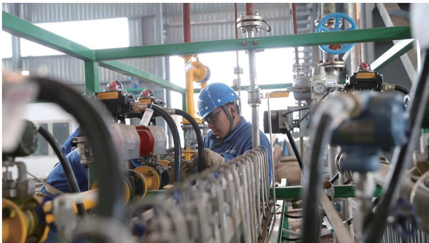
通，为后续联动试车及点火生产打好“提前战役”；作为该项目施工量最大的管道安装工程，经过该公司参战职工连续5个多月奋战，循环水系统和高压风机系统已经全部完成，并实现了带压贯通测试，室内外氮气和氧气管道也已经全部到位，完成了打压、吹尘。天然气管道已经就位，正
