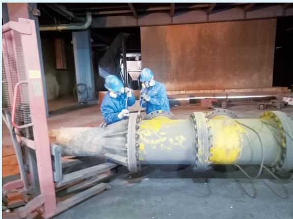
维修工正在拆卸喷枪螺丝。
