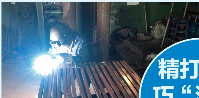
维修师傅们在修复老化导电棒。
