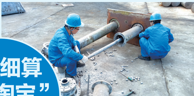
维修人员改造修复老化循环立泵。
