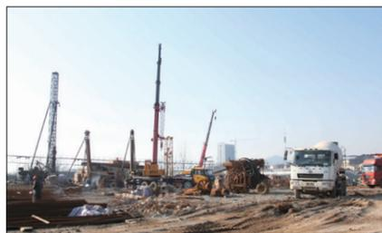
经过近3个月的努力，该项目施工进度明显加快。截至17日，全部钢结构管网已经分布到位，正在进行最后的焊接施工；第一台酸罐桩基已经完成10根；东线道路已经完成水稳层和混凝土浇筑施工。整个项目有望在春节前取得阶段胜利。
