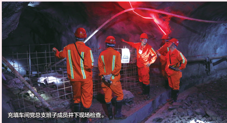
党员尾矿库抢险。
