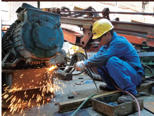
8月28日,井巷公司机修车间维修班为确保丰山盲井设备设施按时间进度下井安装,职工在高温下抓紧准备。
