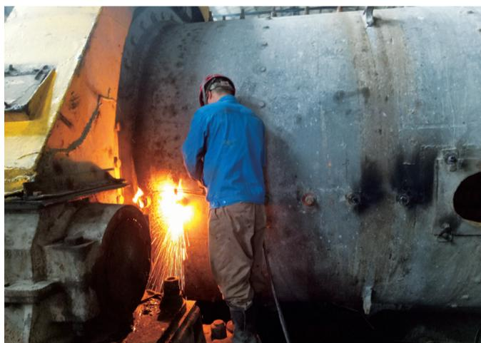
**本报讯** 6月28日，随着最后一块衬板的拆除完毕，机电修造公司丰山项目部整台球磨衬板拆除工作完美收官。
