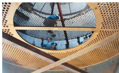
行轨道铺设，新的转换器也已经在另一侧平台上完成壳体组装，内部三层支撑板和两层折流板也完成定位，正在进行定位管的穿插作业。据悉，新转换器重难点工程在于2000多根的换热管和20多根定位管的穿插作业，作业人员将采用多班轮换不间断进行安装焊接，争取一周内完成。
