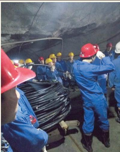
2月28日，井巷公司机关党支部组织18名由党员和团员为骨干组成的突击队，到铜绿山矿井下-605米至-665米斜坡道分层巷，配合人手不足的机电安装项目部开展了分层巷动力电缆下放安装劳动，以实际行动服务和助力工程建设。
