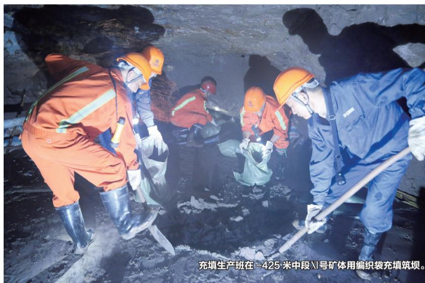
充填生产班在-425米中段XI号矿体用编织袋充填筑坝。
