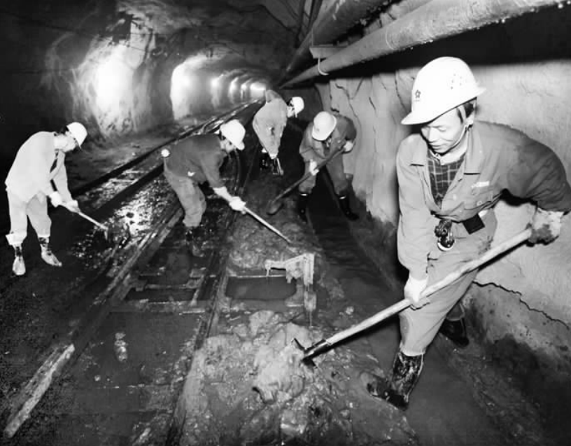
▲24日,井巷公司组织机关20名管理人员参与铜绿山矿项目部负425米至负465米中段斜坡道的环境治理工作。经过一天的努力,400米长斜坡道的环境面貌焕然一新。这是该公司切实加强机关干部作风建设的系列活动之一。郭小勇 摄
