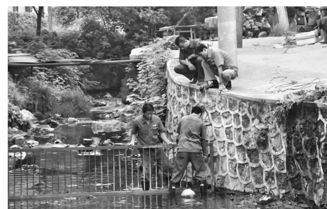
▲9月16日,丰山铜矿生活服务公司组织党员对矿区中心河沟垃圾进行了清理疏通,并在河沟内安装了过滤器,不让垃圾流入湖泊,确保了河沟清洁,流水畅通。这是该矿生活公司党员在中心河沟内安装垃圾过滤器。严鹏芳、刘鑫涛 摄
