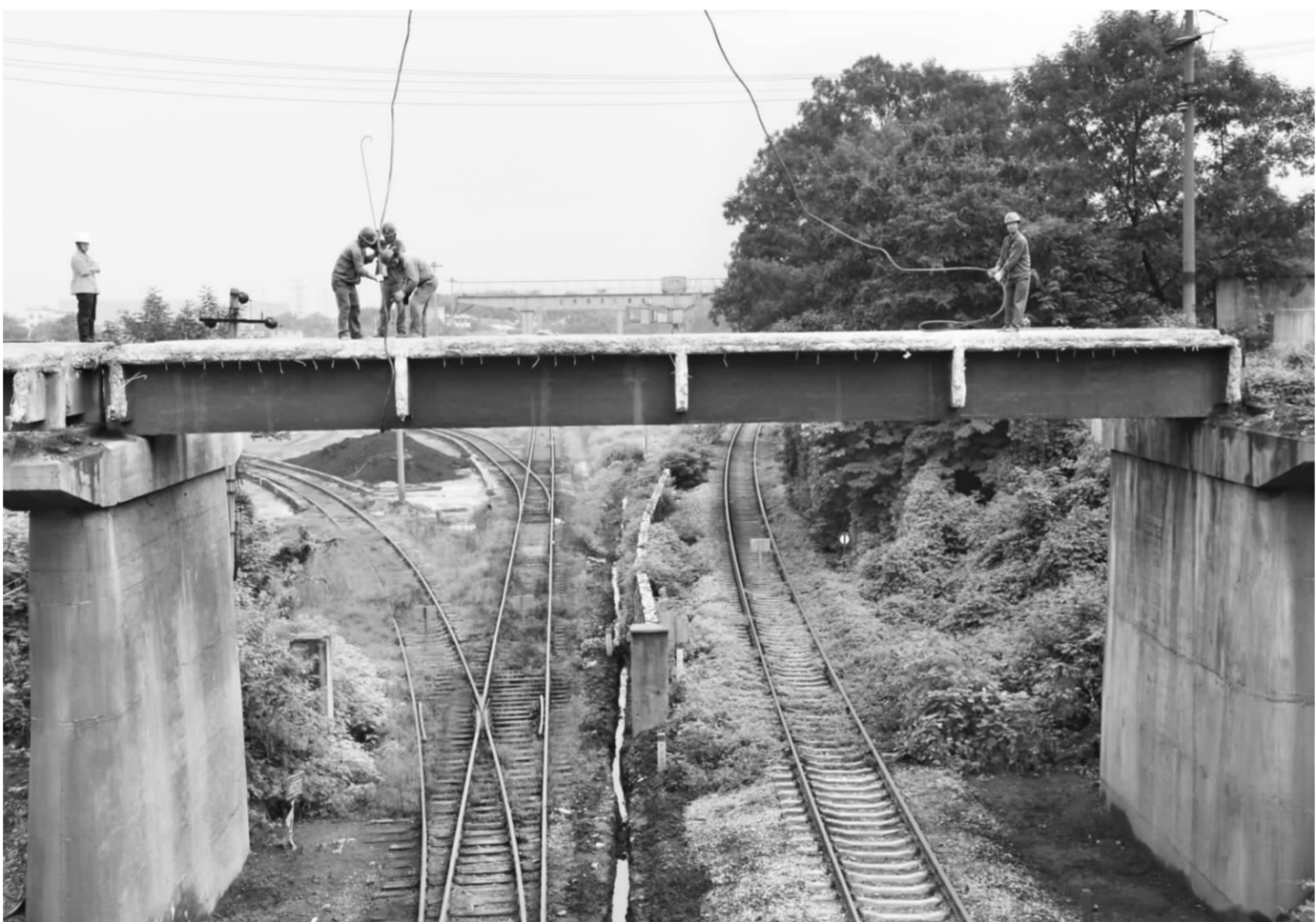
▲这是在旧桥梁拆除中,职工们一丝不苟地做好吊装前的索绳锁定、绑实等工作。程玲 摄
