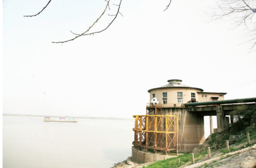
▲ 动力分公司供水一车间长江泵房
