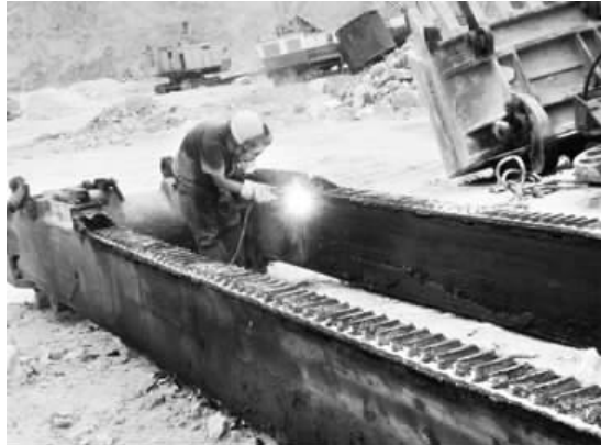
8月19日起,机电修造公司铜山口项目部维修一工段维修工连续加班作业一周,将露天采场5号电铲大架、铲杆及铲斗成功修复,修复价值达5万元。 黄臣 摄
