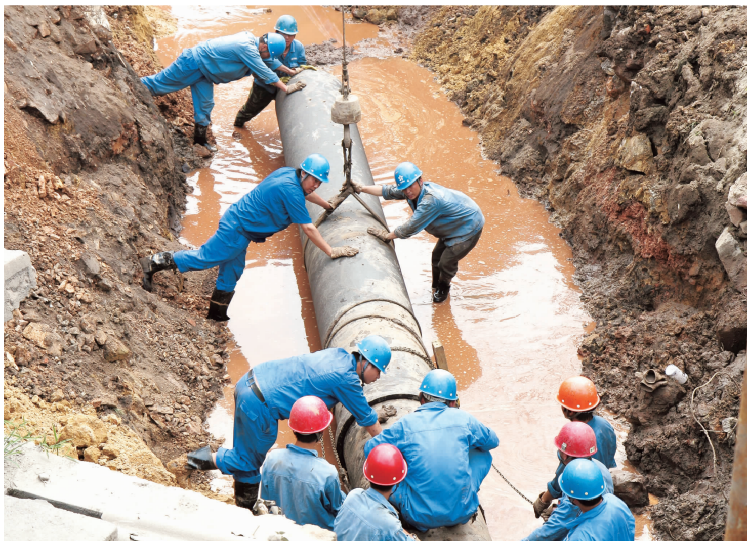
▲7月份,在铜绿山矿混合井塔及磨浮改造工程外圈管道施工中,管道安装公司职工们正在埋设安装生产给水、矿浆等工艺管道。
