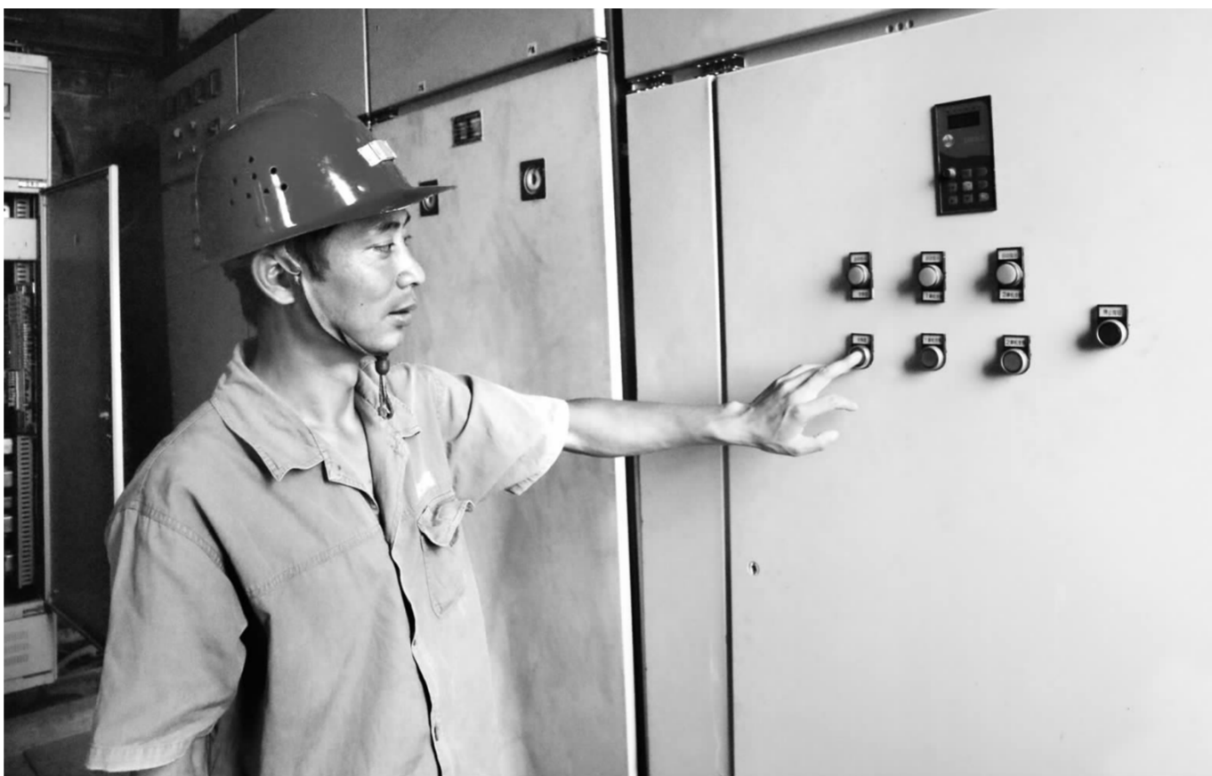
▲ 选矿车间脱水大班砂泵工正在启动砂泵变频器。 刘志勇 摄
