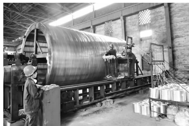
▲7月6日,由建安公司承建的冶炼厂硫酸尾气深度脱硫工程中的玻璃钢烟气管道制作完成。据悉,玻璃钢管道相比尾烟烟筒具有加工方便,安装简单,重量轻,强度高,刚度大,在高温下耐腐蚀性能优良等特点。该公司职工克服人员少、任务重、工期短等困难,保质保量地完成了玻璃钢烟气管道制作任务。 陈祥 摄
