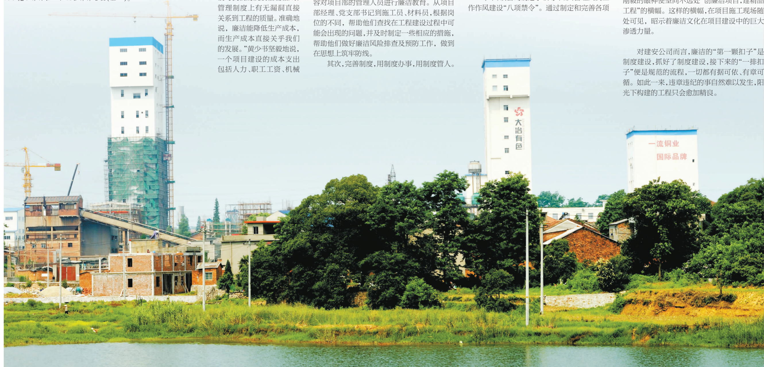
▼这是建安公司第一工程项目部承建的铜绿山矿X矿体开拓工程混合井塔楼(左一)。
