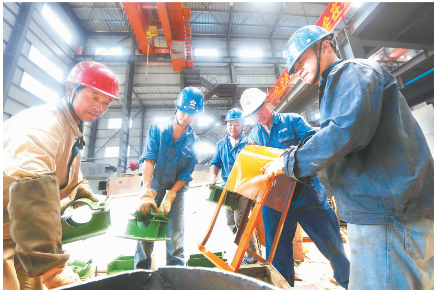
▲这是建安公司第一工程项目部职工在铜绿山矿选矿扩能改造工地上作业时的场景。
